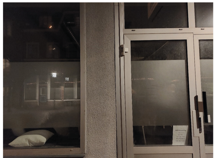
Skyltfönster på Kungsgatan - även om verksamhet bedrivs här så skulle man istället för "mjölkade" fönster ordna trevligare insynsskydd.
