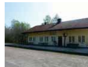
Stationsbyggnad i Bolmen samhälle.
