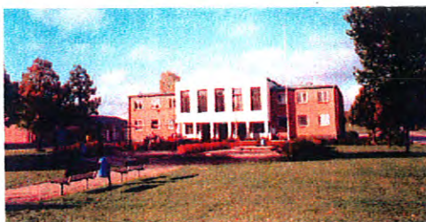
Torget med gamla kommunalhuset.
