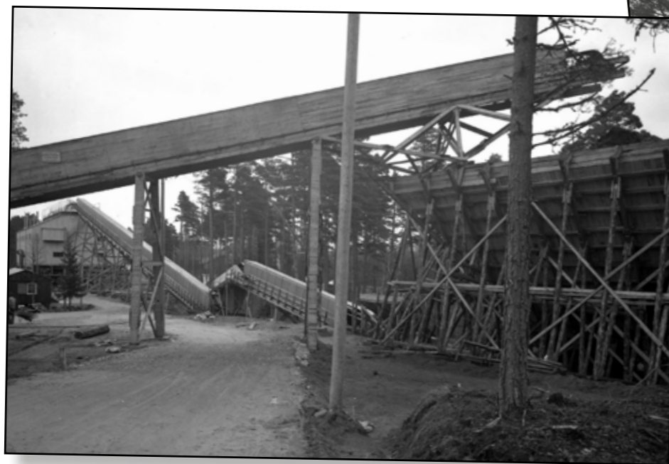
Torven fördes via transportörer upp till fabriken tak.
