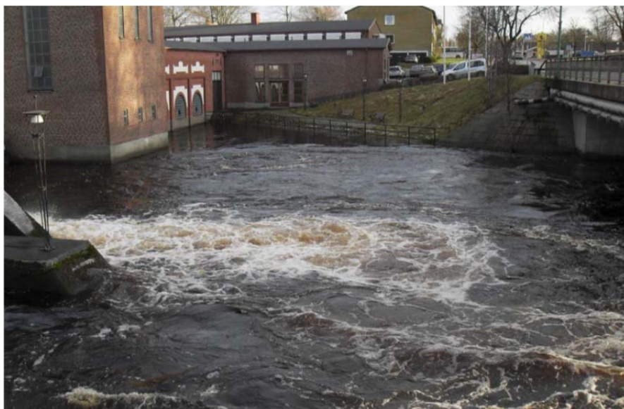
Ljungby Energi vid Vislandavägen.
