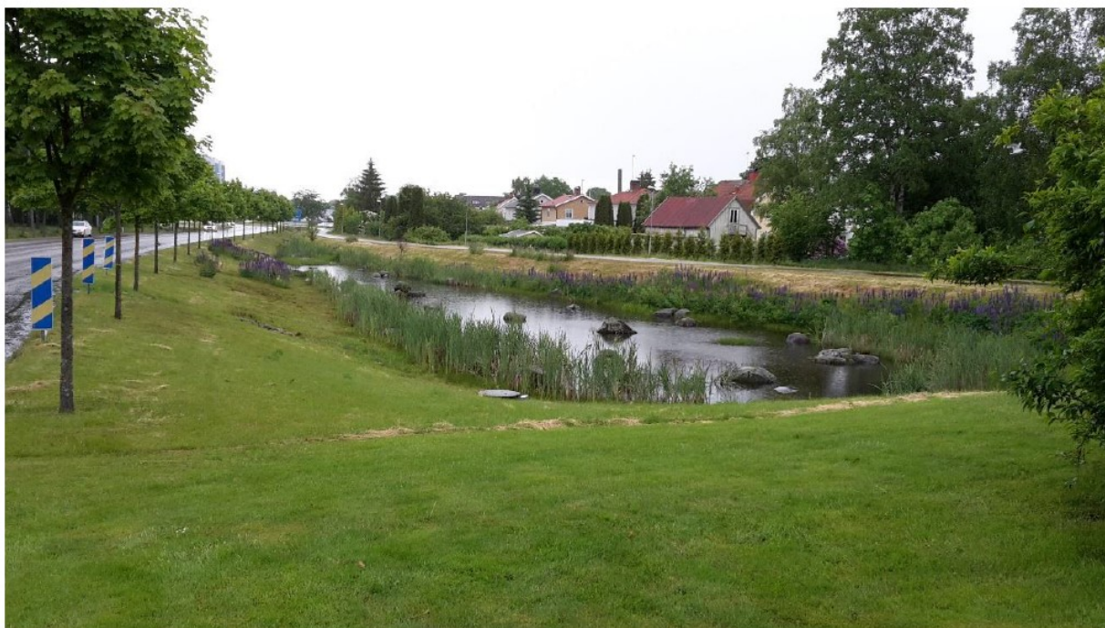
Dagvattenanläggning vid Helsingborgsvägen. Källa: Tyréns
