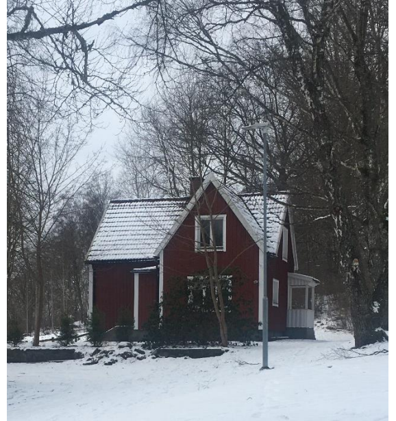
Befintlig byggnad inom fastigheten Giraffen 4.
